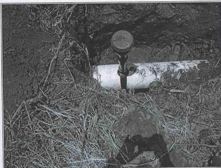
Instalación de válvula expulsora, para evitar rompimiento de tubería
