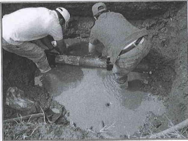
Reparación de fugas en líneas de conducción y distribución
